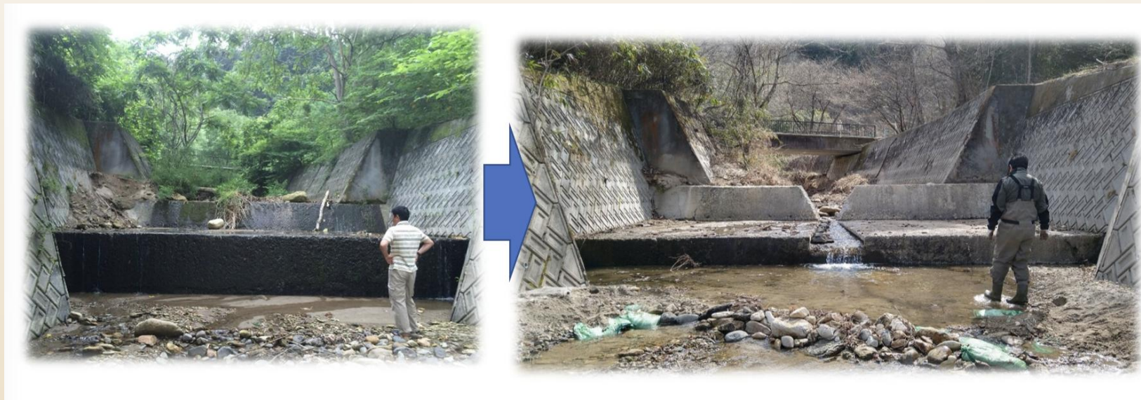
竜の口溪谷の切欠き魚道（林田寿史氏 | 土木研究所 自然共生研究センター 資料より）
