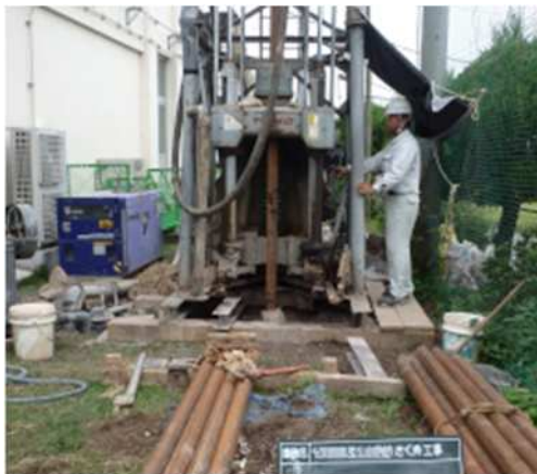
ボーリング工事
